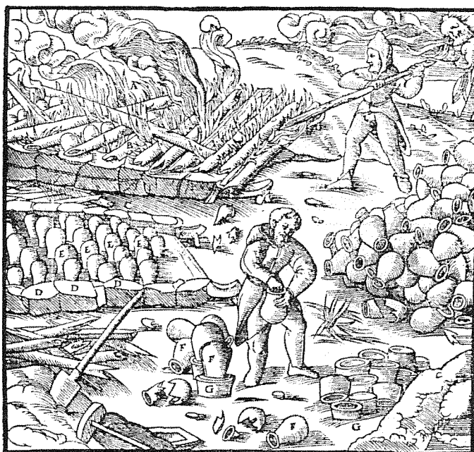
Die brennende Feuerstätte A. Die Hölzer B. Die nichtbrennende Feuerstätte, in welche die Töpfe eingefert werden C. Die Steine D. Die Topfröhren E. Die oberen Töpfe F. Die unteren Töpfe G.
